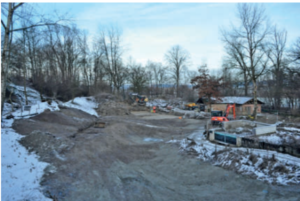
Der Aushub ist abgeschlossen und die Abdichtungsarbeiten stehen bevor (Stand 14.01.2026).
