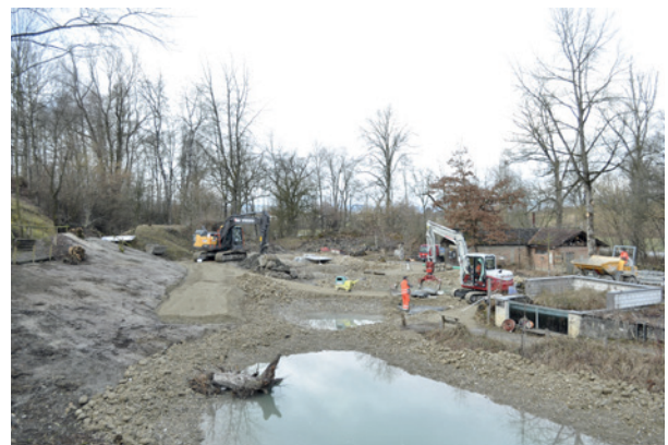
Neues Laichgewässer entsteht
