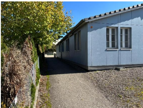
Abb. 17: Blickrichtung Osten Durchgang Postgebäude
