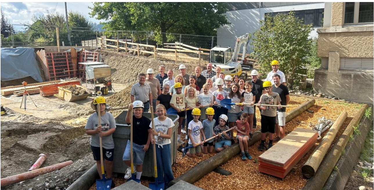
Spatenstich: Mischklasse 5./6. Klasse von Dominik Wangler, Baukommissions-Mitglieder, Gemeinderat inkl. Gemeindeschreiber, Planer und Baumeister.
